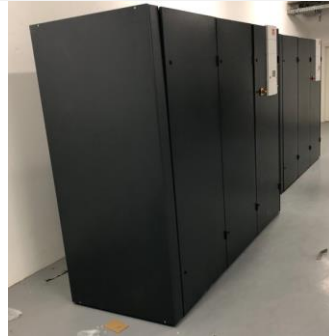
Armoires de climatisation Réseaux d'eau en faux plancher
