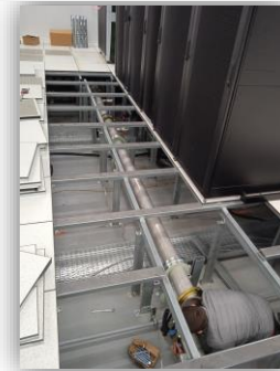
Armoires de climatisation Réseaux d'eau en faux plancher
